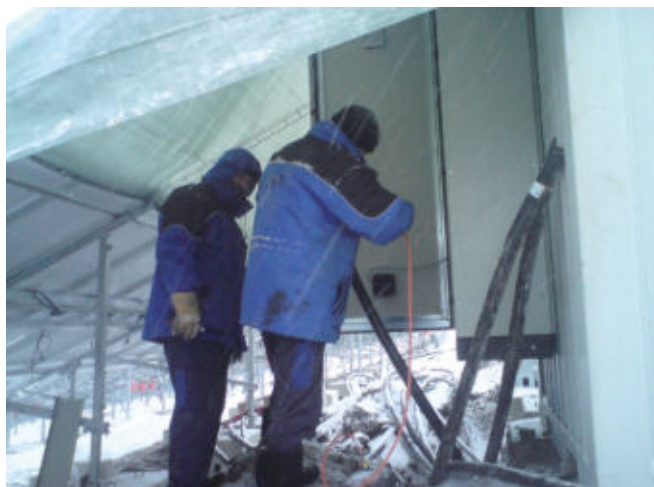
Obr. 1: Práce v zimním období pod provizorním krytem z plachty
