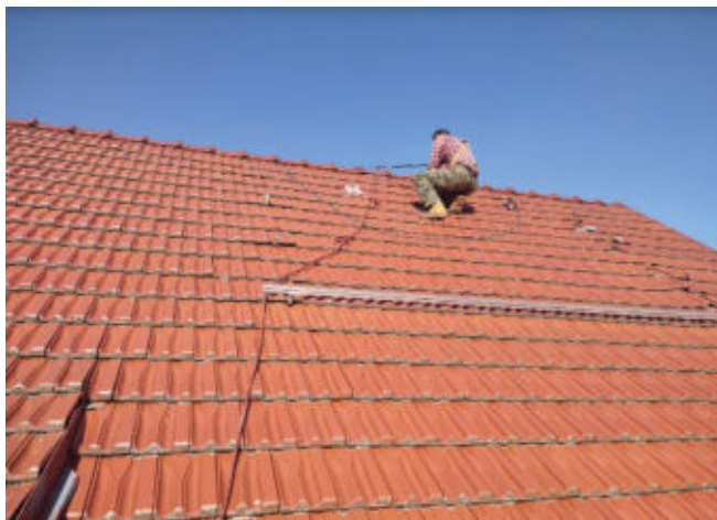
Obr. 2: Montáž hliníkových lišt pod krytinu
