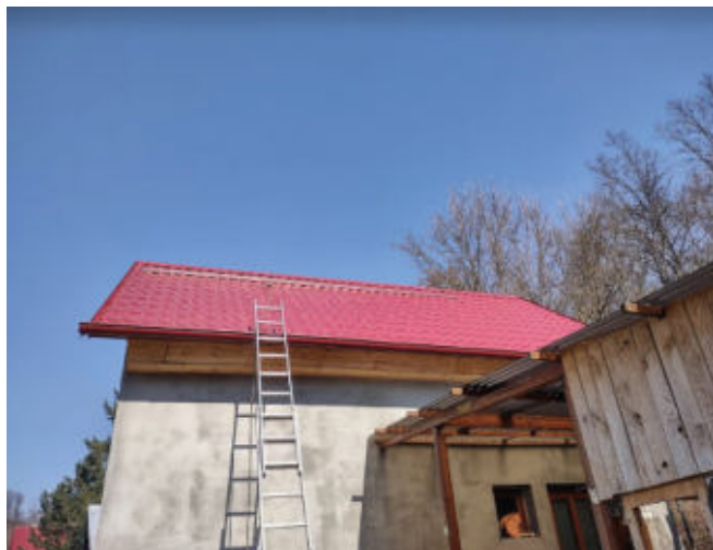
Obr. 3: Střecha připravená k montáži panelů
