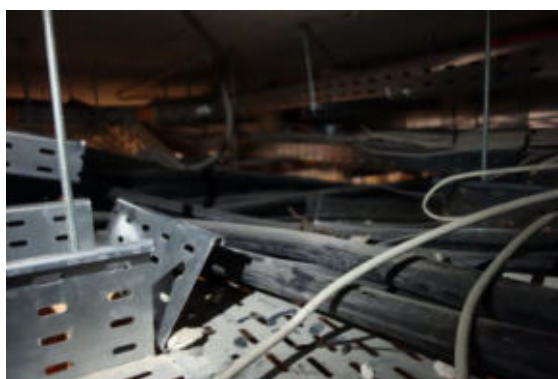
Detail na ostrou část uvolněného žlabu
