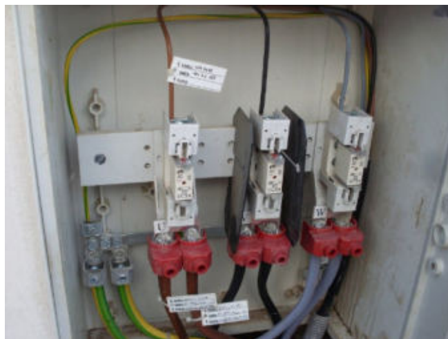
Obr. 5: Pojistková skříň s osazenými pojistkami.
