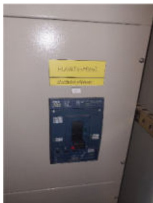
Obr. 6: Hlavní vypínač pro zařízení
