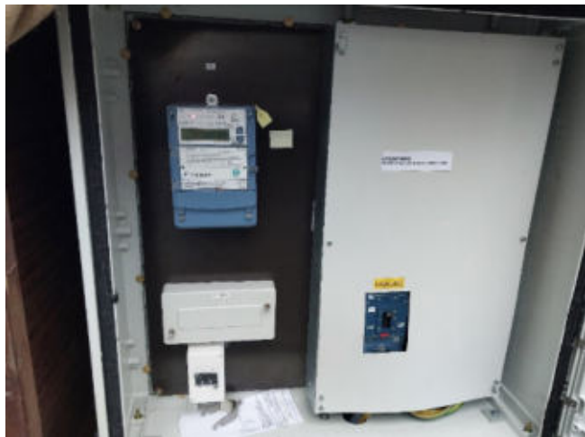
Obr. 7: Příklad rozvaděče nepřímého měření pro akce výstavy a trhy
