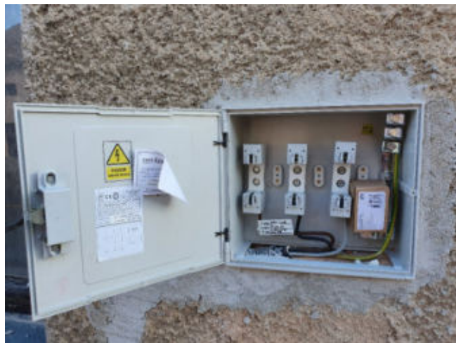
Obr. 4: Ukázka pojistkové skříně s neosazenými pojistkami
