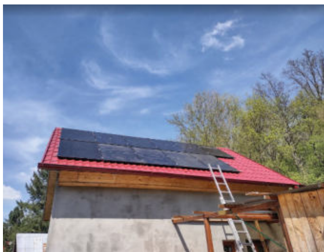
Obr. 4: Panely osazené na střechu
