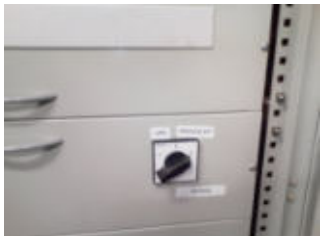
Obr. 10: Přepínač sítě-UPS (stav při poruše zařízení UPS)
