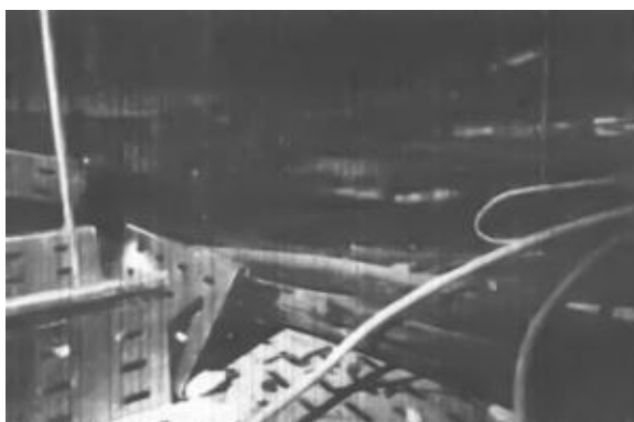
Uvolněný a nezajištěný kus žlabu
