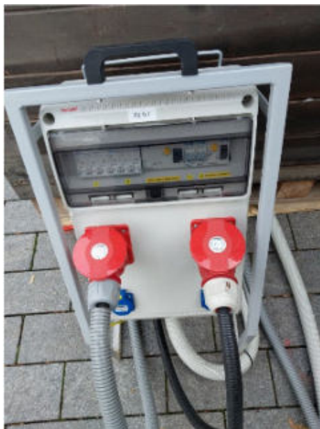
Obr. 12: Příklad rozváděče pro stavební účely
