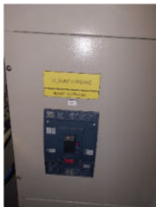
Obr. 5: Hlavní vypínač pro zařízení
