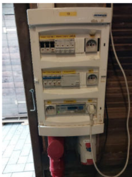
Obr. 13: Rozváděč pro použití ve stáncích v rámci výstav a trhů
