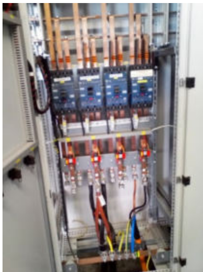
Obr. 2: Výkonový rozváděč s jističným pohonem (modeiony)
